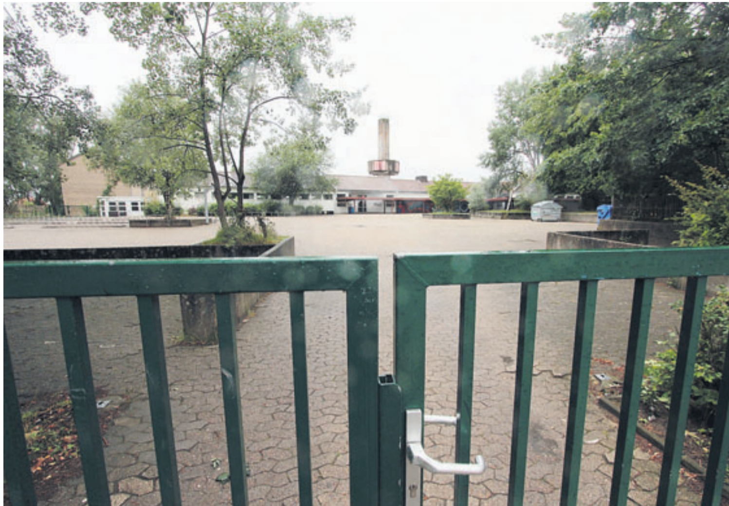
Durch dieses Tor werden keine Schüler mehr gehen: Das Realschulgebäude an der Lange Straße wird voraussichtlich ab Anfang November abgerissen, um Platz für einen Neubau zu machen. Dieser soll bis zum ersten Quartal 2013 fertiggestellt sein. FOTO: MICHAEL RABBA
